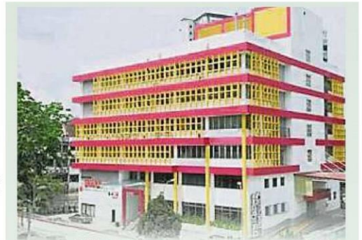
锋利集团子公司 Sharp Die Cutting Mould 私人有限公司, 坐落在旧巴生路。
